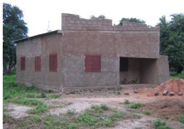
Rohbau des Radiosenders von JARABE in Benoye
